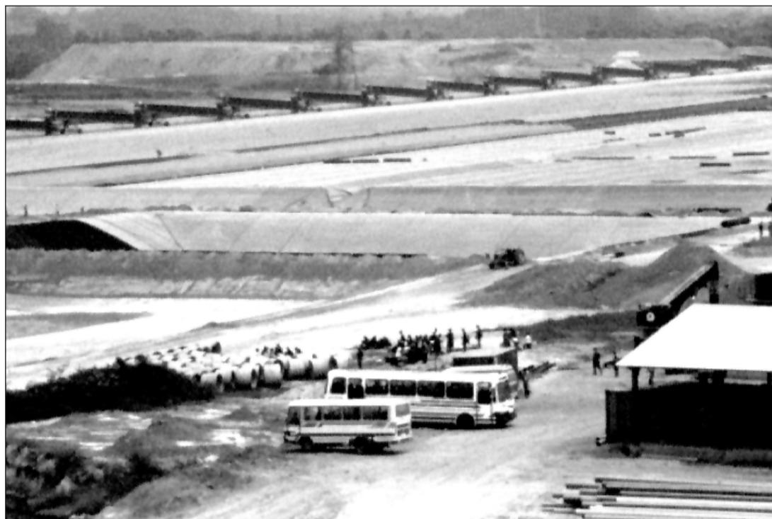
Preparación de plataformas recubiertas para la lixiviación con cianuro, mina de oro de Tarkwa, Ghana
